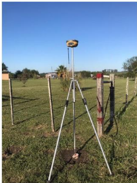
Figura 6 – Instalación puntos fijos
